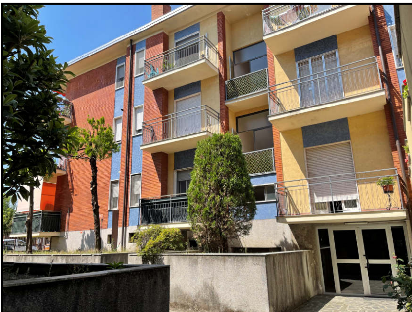
Vista da cortile interno
